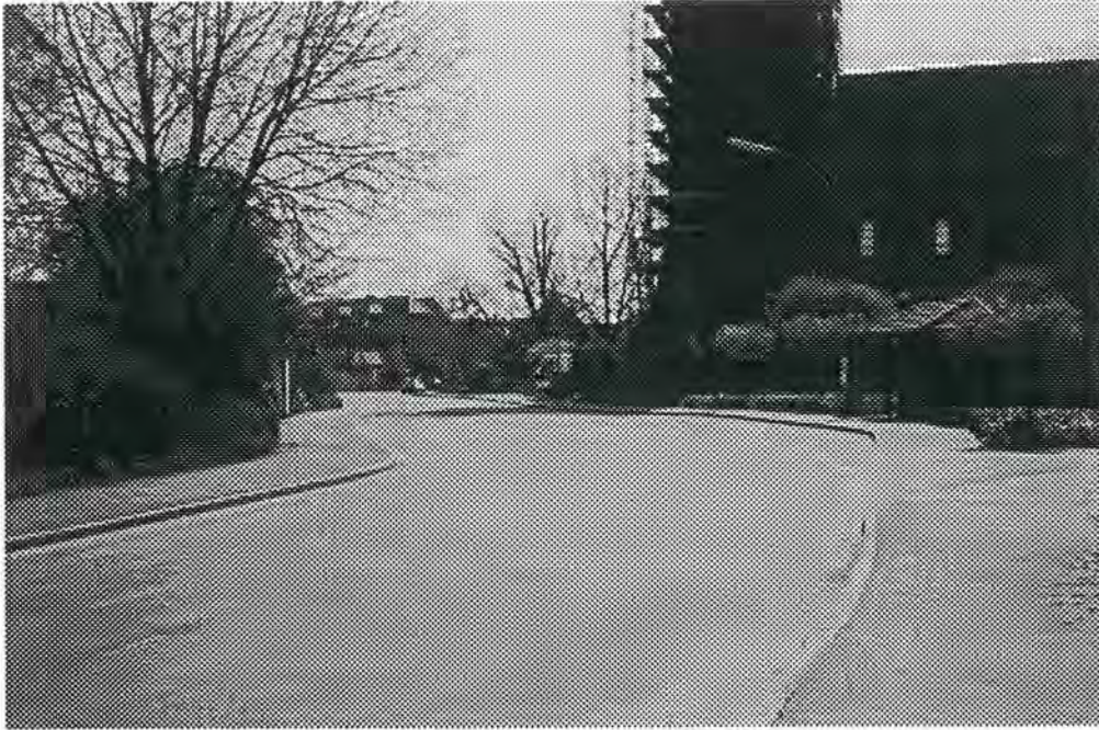
Ortsdurchfahrt im Bereich der Pfarrkirche
