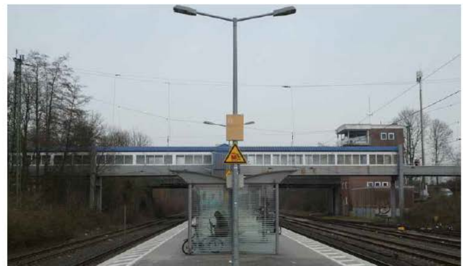
Bestand: Bereich - Bahnüberführung
