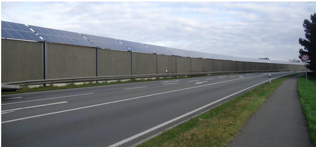
Abbildung 52: PV-Anlage an einer Lärmschutzwand in Wietmarschen (Quelle: Gemeinde Wietmarschen )
