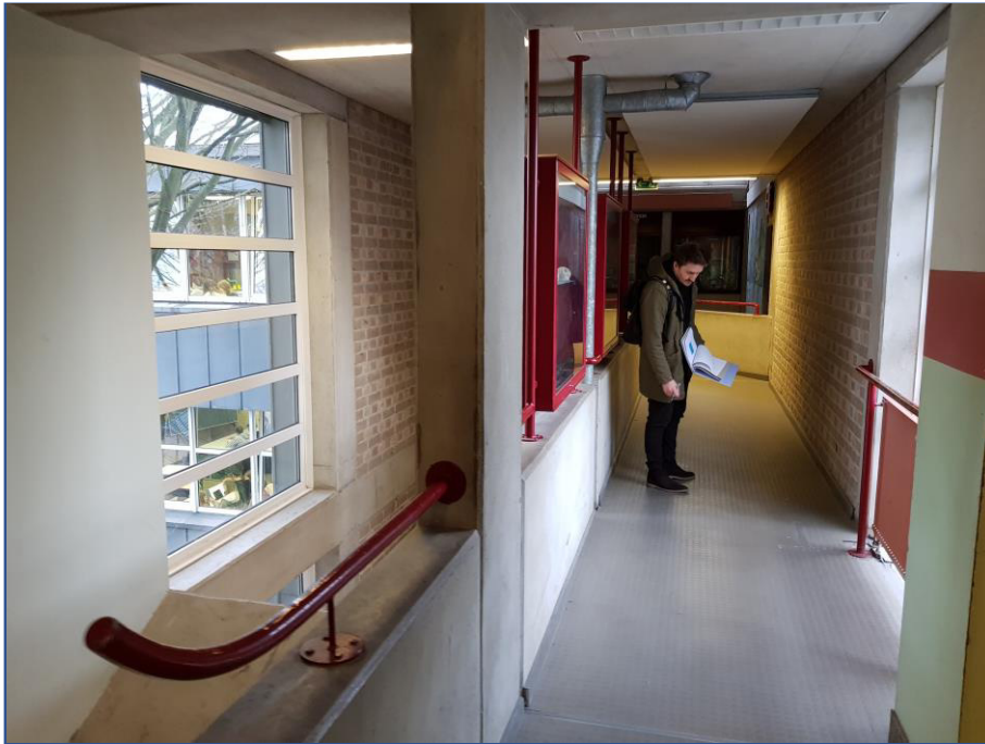
Übergang Hauptgebäude – Nebengebäude mit diversen Niveausprüngen
