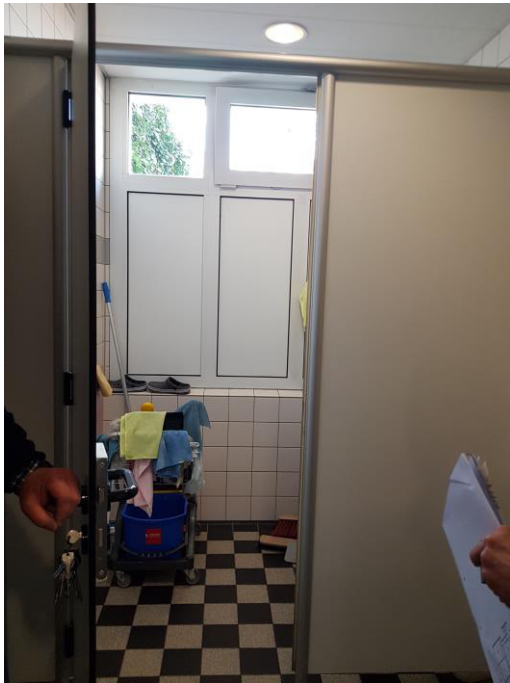
Fehlende Lagerräume für das Reinigungspersonal
