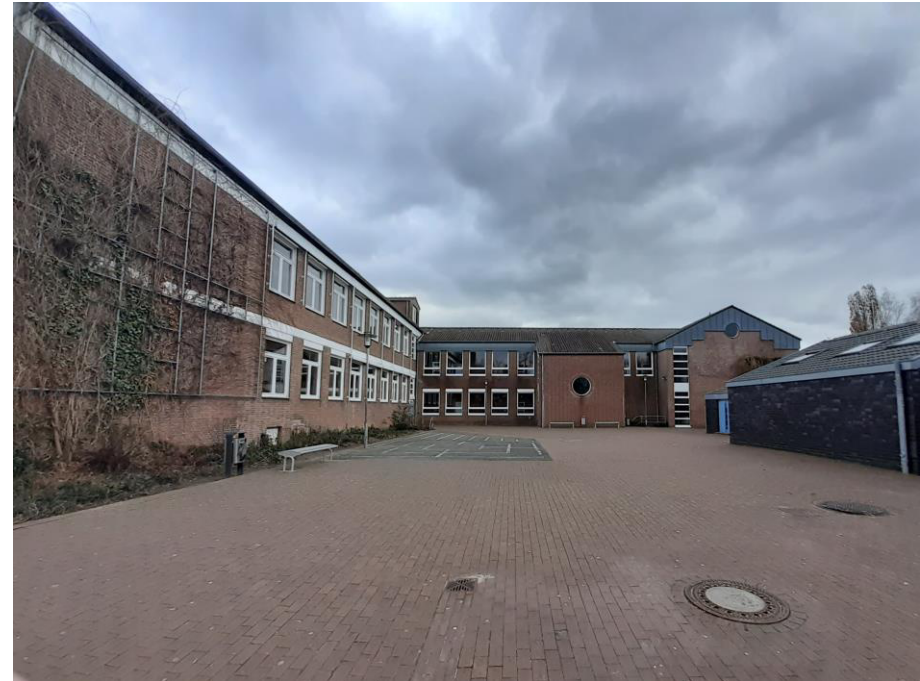
Pausenhof und zentraler Eingang
